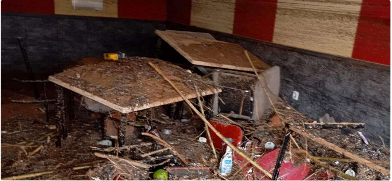
El interior de un bar de la zona, tras el paso del agua y el fango.
